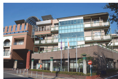
船橋市ケアリハビリセンター 船橋市リハビリセンターと ケアハウス市立船橋長寿園 が併設
